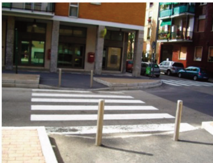
dopo gli interventi
